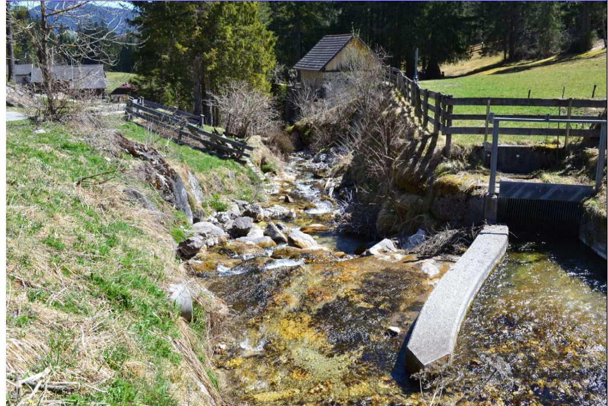
Konzession D/8397 Fassungsbauwerk und unüberwindbare Schwelle
